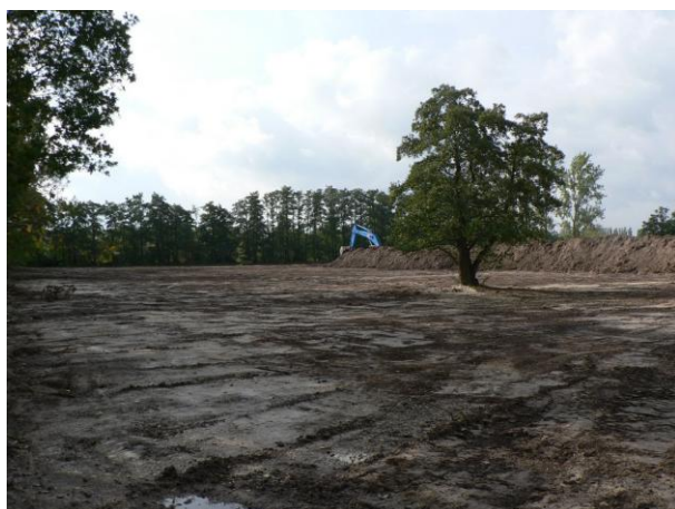
Afb. 1 afgraafwerkzaamheden in oktober 2012
